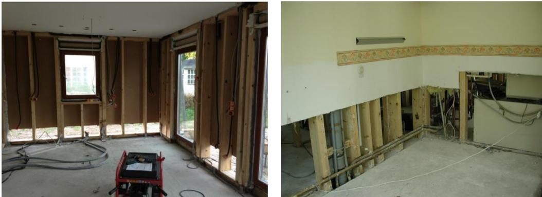
Abb. 7 und 8: Geöffnete Holzrahmenkonstruktion - Außen- und Innenwand
