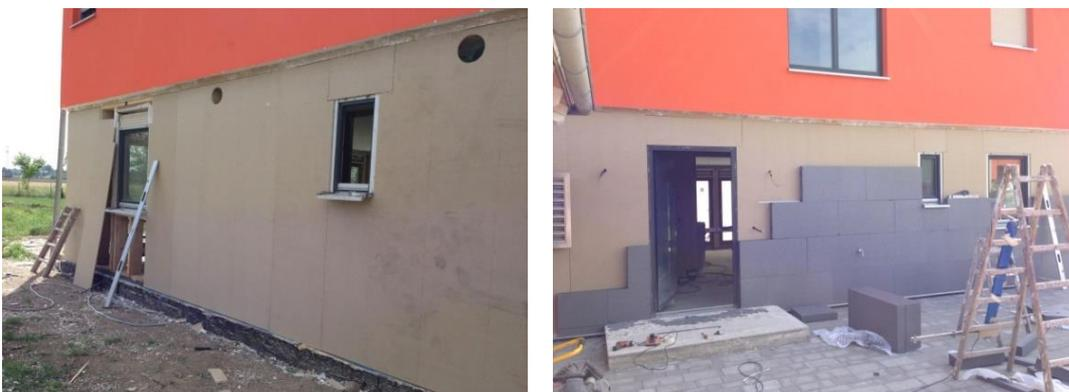
Abb. 20 und 21: Anbringen der Außenbeplankungen und der neuen Putzträgerplatten
