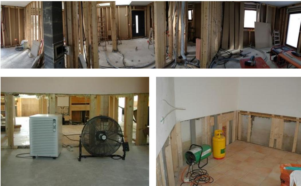
Abb. 15, 16 und 17: Trocknung mit allen technischen Möglichkeiten (z. B. Heiz- und Trocknungsgeräten, Ventilatoren) an der geöffneten Konstruktion durchführen
