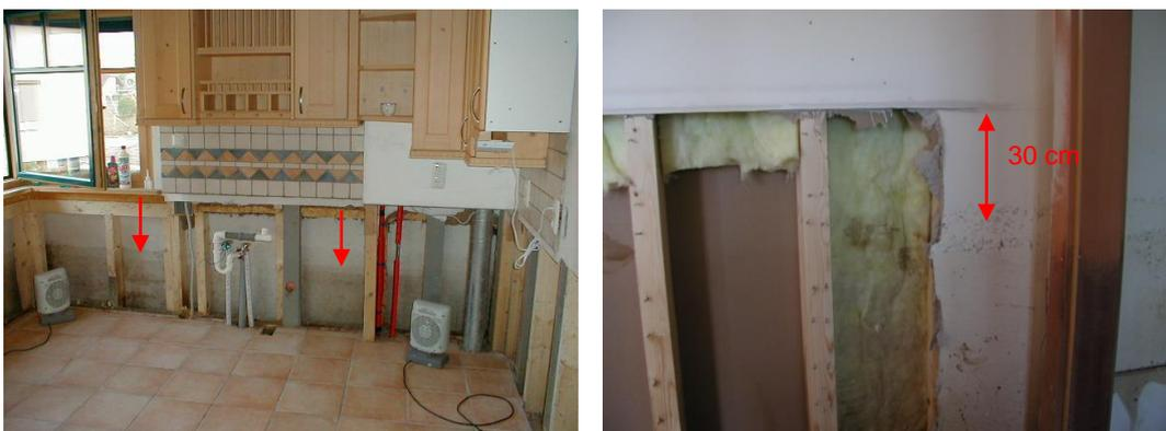
Abb. 1 und 2: Geöffnete Wandkonstruktion innen - bis 30 cm über der Hochwassermarkenlinie
