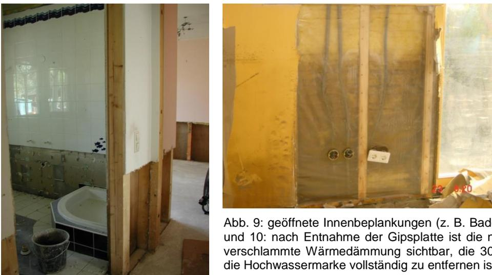
Abb. 9: geöffnete Innenbeplankungen (z. B. Badezimmer), und 10: nach Entnahme der Gipsplatte ist die nasse und verschlammte Wärmedämmung sichtbar, die 30 cm über die Hochwassermarkenlinie vollständig zu entfernen ist.
