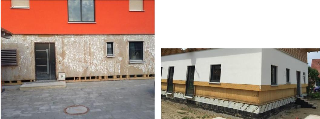
Abb. 11 und 12: Das durchfeuchtete Wärmedämmverbundsystem (WDVS) muss entfernt werden
