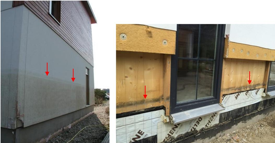
Abb. 3 und 4: Die Hochwassermarken sind außen am Putz und an der Brettsperrholzwand gut erkennbar
